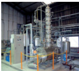
静岡油化工業 小型バイオマスエタノール製造プラント
