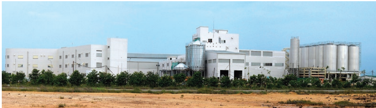
ベトナム ホーチミン市郊外に建設中のロンアン工場(2011年6月29日撮影)
