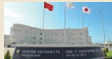
サッポロベトナム社 ロンアン工場(ベトナム)
