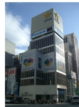
サッポロ銀座ビル (1970年竣工)
