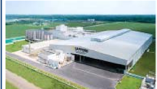
サッポロベトナムロンアン工場
