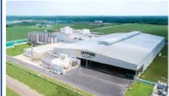
サッポロベトナムロンアン工場
