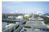
● サッポロビール千葉工場
