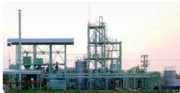
サッポロビールと磐田化学工業が開発した高温発酵酵母による、タイ国初のキャッサバパルプを原料としたバイオエタノール製造プラントが2014年に竣工
