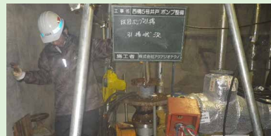
西構5号井戸のポンプ整備の様子。
